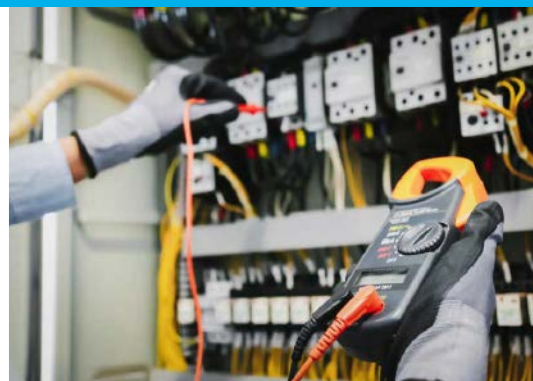
Instalación de Tableros Eléctricos y Bandejas Eléctricas
